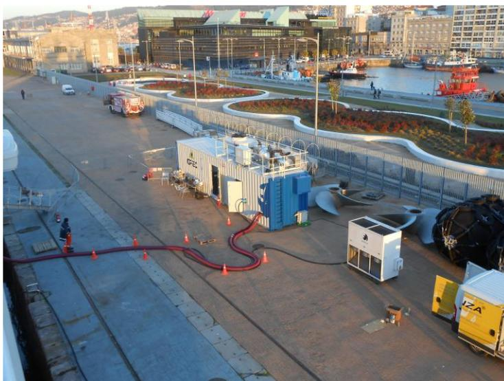
■ Figura 11: Proyecto GPEC. Sistema contenerizado clusterizable de poligeneración que suministra energía eléctrica y térmica a buques.
