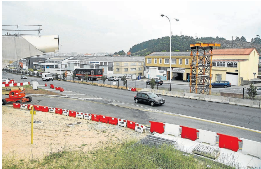
La estructura metálica que soportará la pasarela se montó en menos de un día | QUINTANA
