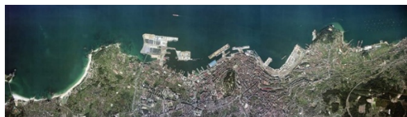
Vista aérea del Puerto de Vigo (World Port Source).
