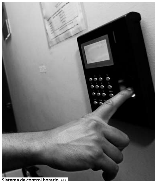
Sistema de control horario. AEP
