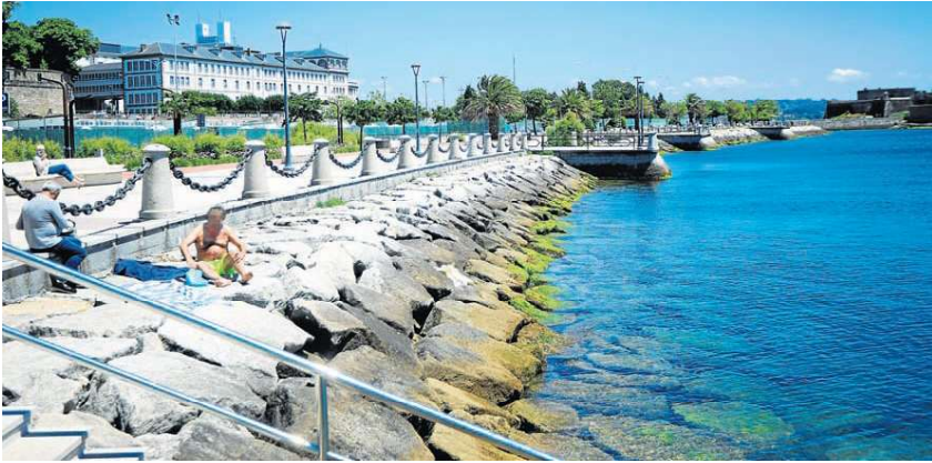
Vista de la zona de las escaleras que descienden hasta el agua en O Parrote | PATRICIA G. FRAGA
