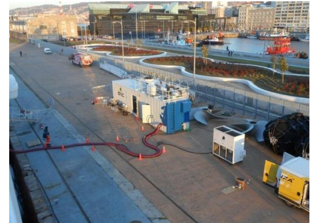
Sistema contenerizado clusterizable de poligeneración que suministra energía eléctrica y térmica a los buques
